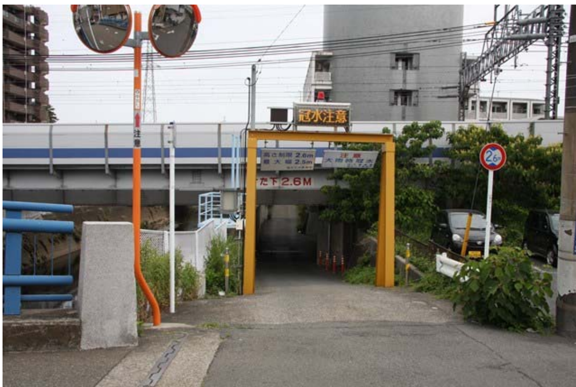
矢上川上流側から
