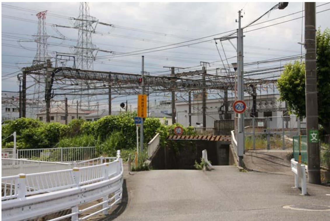
国道 1 号線側から
