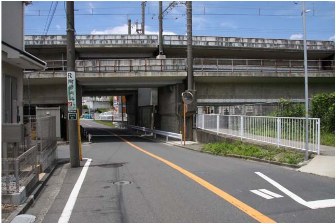
根岸線南側から
