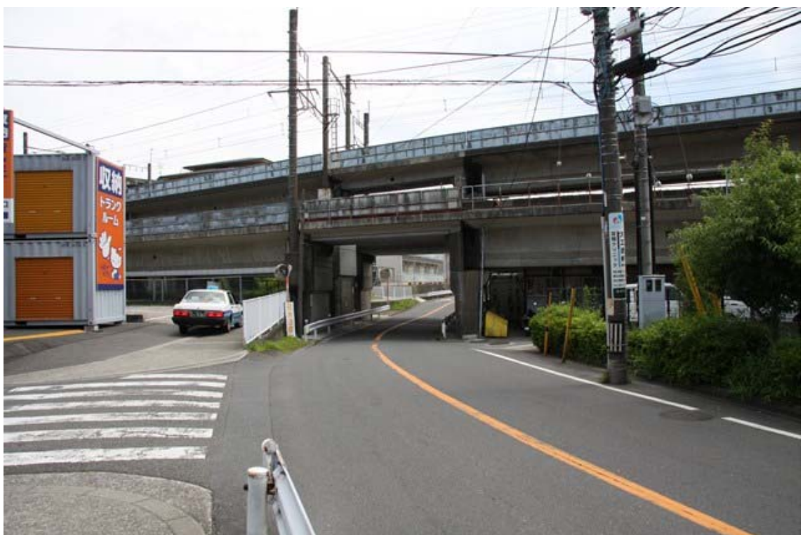
根岸線北側から
