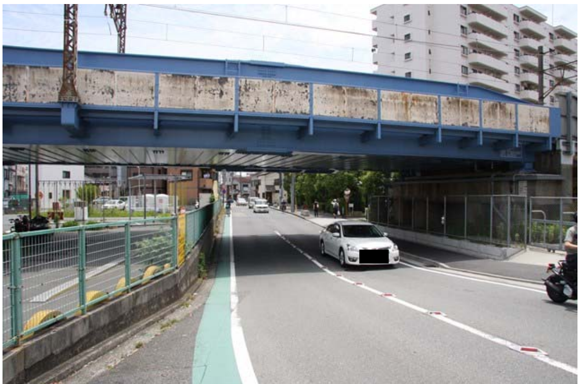
国道 1 号線側から
