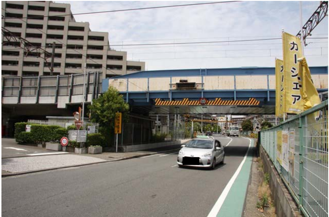
国道 15 号線側から
