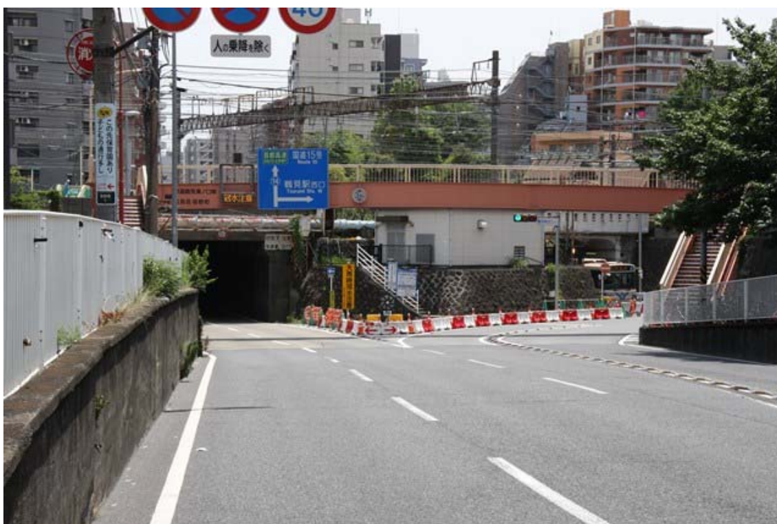
港北区方面側から
