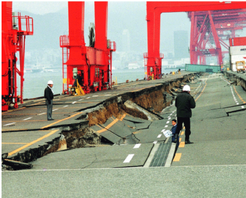
阪神大震災における神戸港ポートアイランド地区の被災状況（資料：国土交通省HP）
