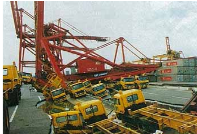
ガントリークレーンの倒壊
