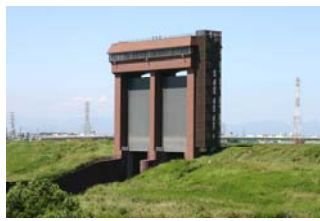
調節池排水門
