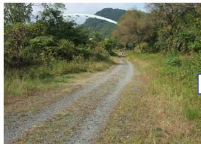
不陸、わだちにより、車両通行時に歩行者が危険
