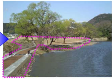
管理用通路、基盤整備、防護柵等の整備により、水辺へのアクセス性、安全性が向上。
