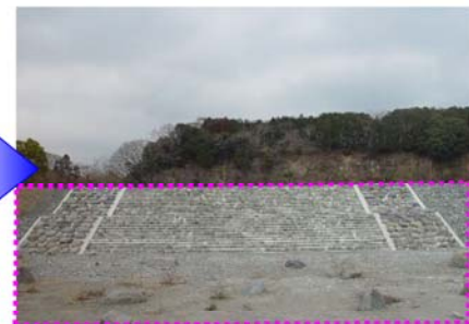
護岸等の整備により出水から河岸を保護すると共に、水辺へのアクセス性が向上。
