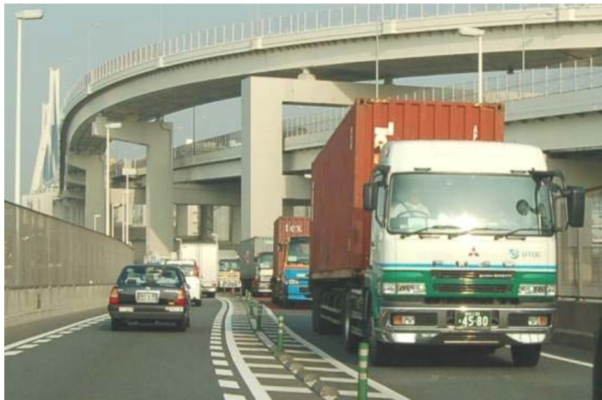
本牧側臨港道路の状況
