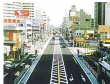
無電柱区間 (国道17号 さいたま市南区白幡地先)
