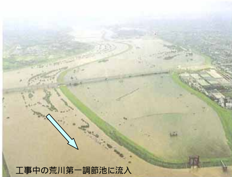
荒川第一調節池
