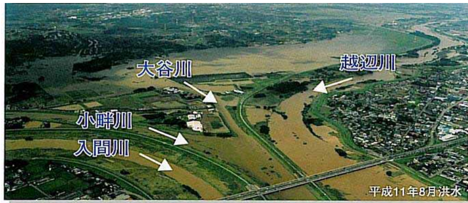
入間川・小畔川・大谷川・越辺川合流部での浸水状況(川越市・坂戸市)
