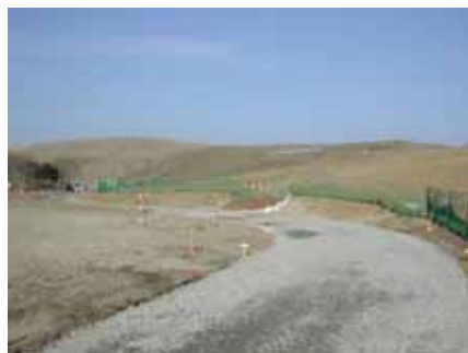
建設発生土を盛土材として活用し 造成したみはらしの丘
