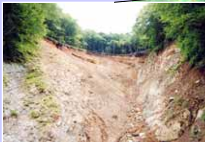
細尾川右支三宿沢大崩壊(平成14年)
