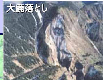
稲荷川源頭部の荒廃地
