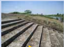
階段護岸・低水護岸
