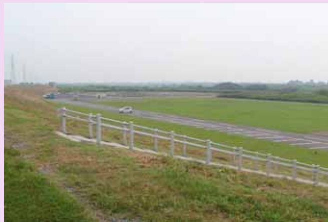
緩傾斜堤防により開放感のある空間が創出された
