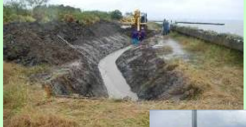
国土交通省(職員の派遣のみ)と公募委員との作業状況(水路掘削作業)
