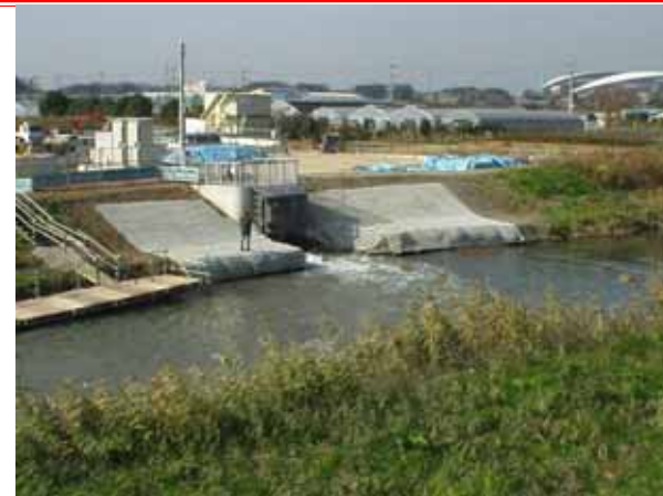
綾瀬川放流口
