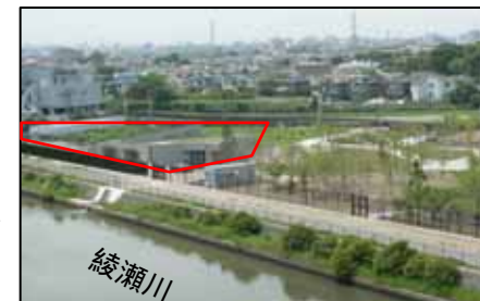
桑袋浄化施設
