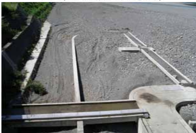
出水後(平成19年9月10日撮影)
