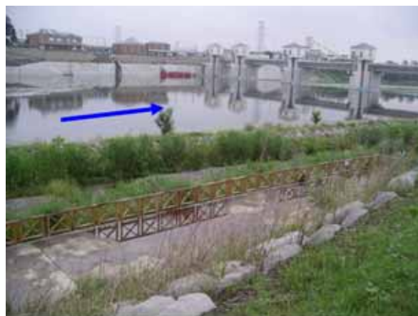
平常時(右岸堤防上より)
