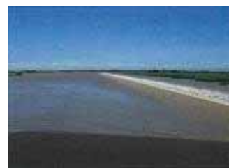
平成14年7月洪水 第1調節池越流堤から池内 に流れ込む濁流(上流側より)
