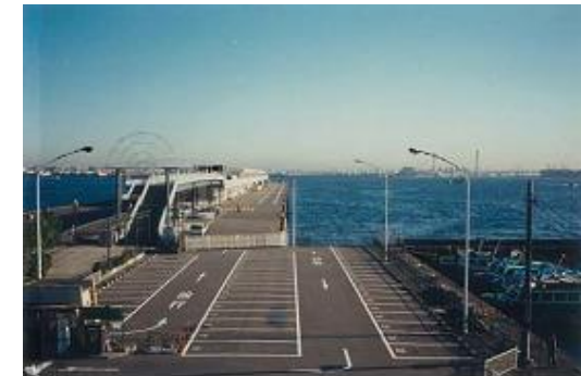
駐車場スペースの不足
