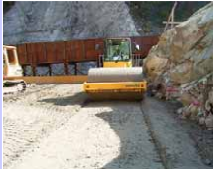
INSEM材締め固め状況
