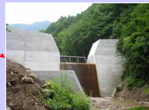
タケノ沢砂防堰堤による土石流・流木対策
