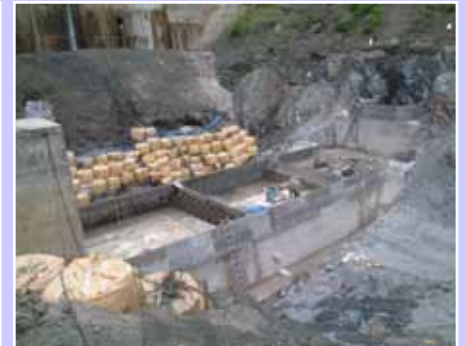
残存型枠施工例
