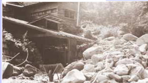
日光沢温泉の 土石流被害 状況 (昭和41年9月24日)
