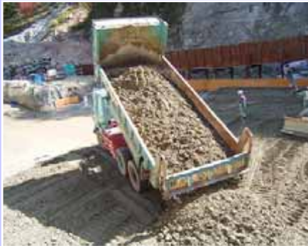
INSEM材運搬・荷卸し状況
