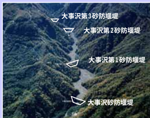
大事沢下流堰堤工群による土砂流出抑止
