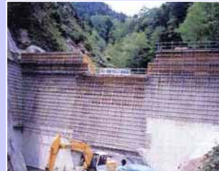
従来の型枠使用による工法
