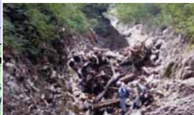
台風13号による五十里ダムへの 流木流入 (平成13年9月12日)
