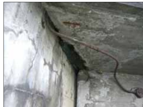
老朽化した落合橋(桁端部の様子)
