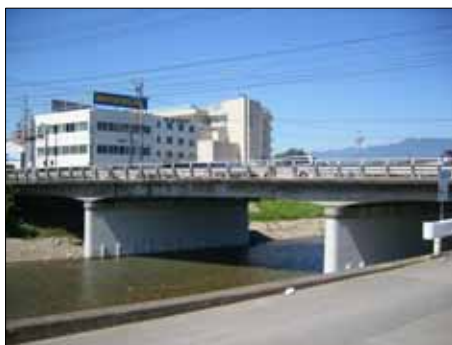
老朽化した落合橋(全景)
