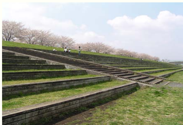
スタンド護岸 (進捗率100%) 板橋区新河岸
