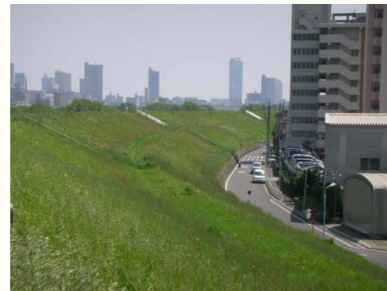
堤防が高く、利用しづらい
