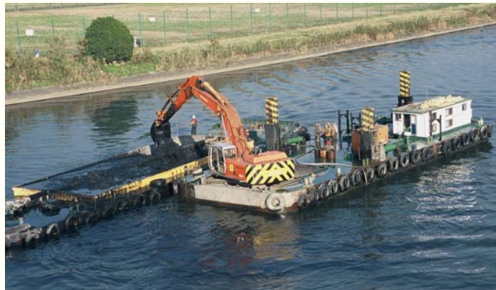
航路浚渫 （実施済み）
