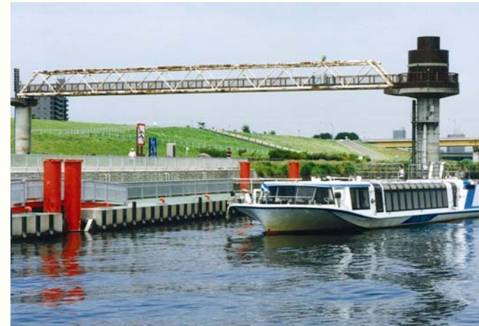
岩淵水門・岩淵リバーステーション (東京都北区)
