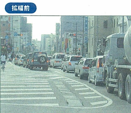
拡幅前の渋滞状況(甲府市寿町)
