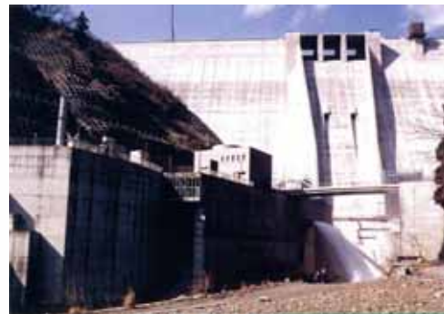
愛川第一発電所
