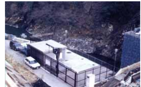
愛川第二発電所
