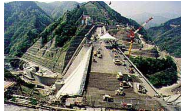
本体コンクリート打設状況
