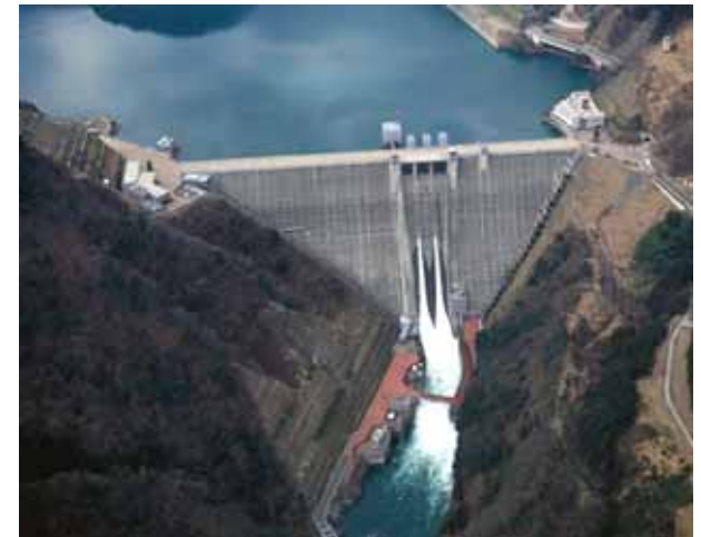
完成した宮ヶ瀬ダム
