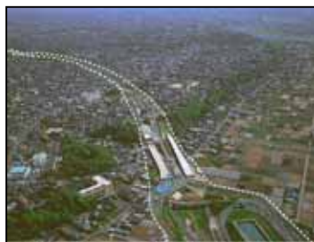
国道6号矢切インター付近
