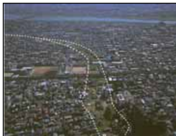
国道14号・ JR総武線交差付近
