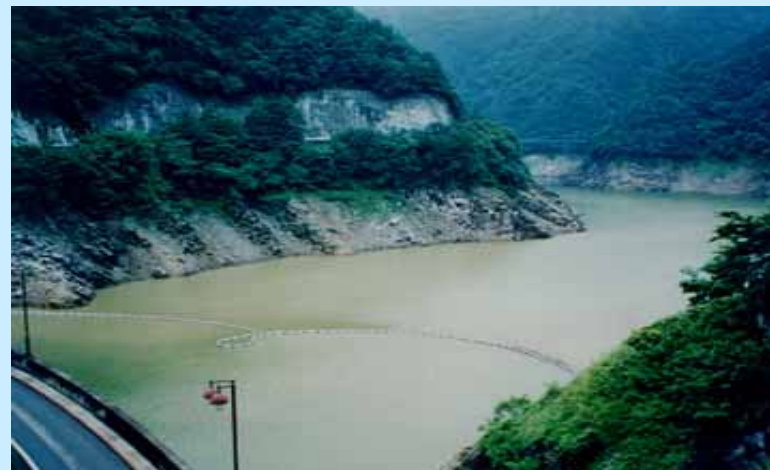
洪水時の二瀬ダム貯水池内の状況
