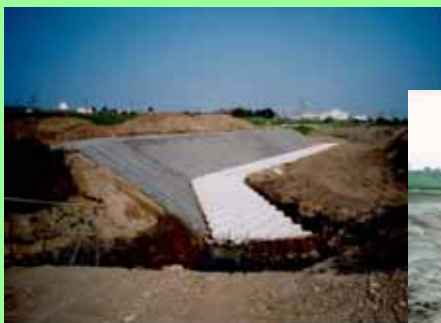
低水護岸施工直後
