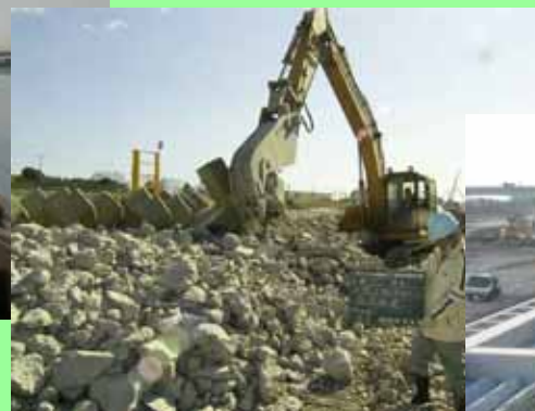
根固めブロック(2t)破碎状況
