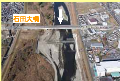
対策工事後 (H17.11)
