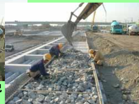
コンクリートガラの利用状況
