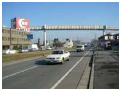
4車整備済区間(若葉区桜木町 四街道方面を望む)
