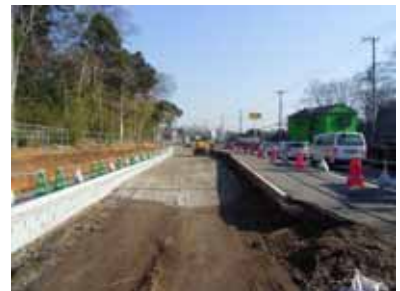
工事中区間(若葉区若松町 四街道方面を望む)
