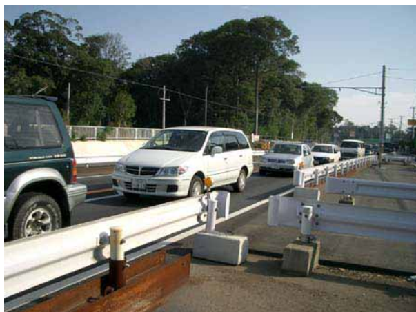
4車線用地買収済み区間 （若葉区若松町 四街道方向を望む）
