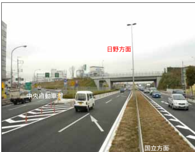
中央道国立府中 IC の現況 平成16年12月撮影
