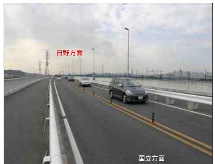
石田大橋の現況 平成16年12月撮影
