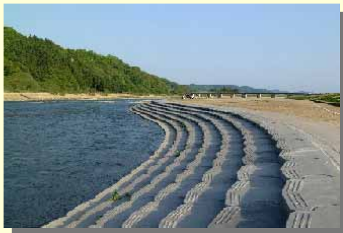
親水護岸(那珂川:栃木県小川町)
