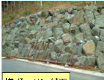
横ボーリング工
