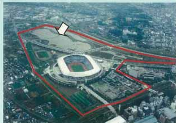
鶴見川多目的遊水地全景 (上の白い部分が鶴見川から越流した洪水)
