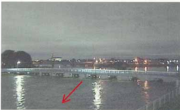
中川出水状況 吉川橋 (31km付近:吉川市吉川地先)
