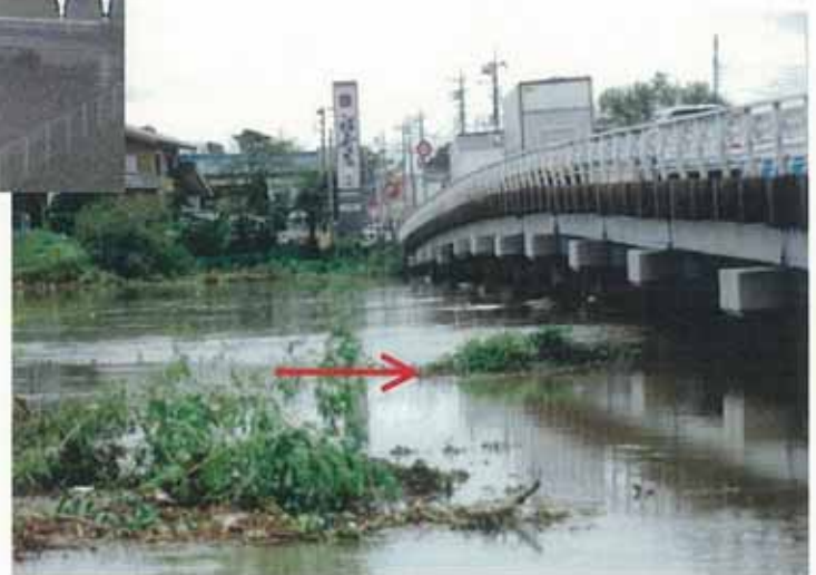
中川出水状況 吉川橋 (31km付近:吉川市吉川地先)
