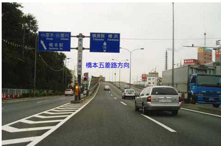
橋本高架橋付近の交通状況
