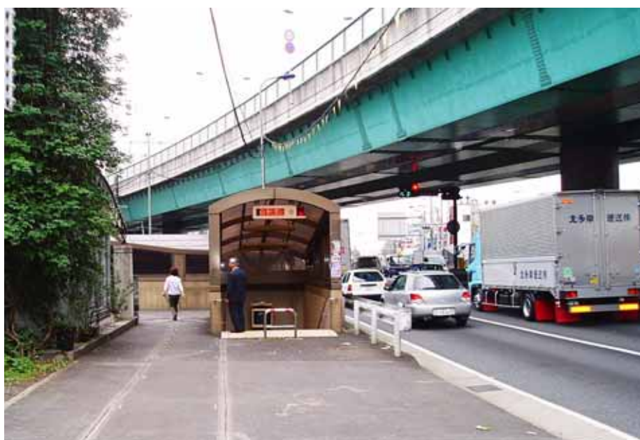
橋本五差路地下道の利用状況
