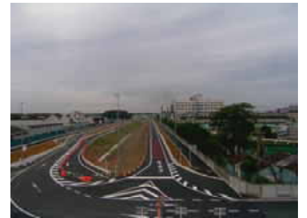
サービス道路等供用状況 (上尾市地頭方地先)
