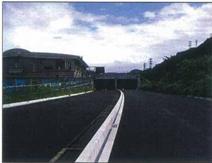
図 本線部の工事進捗状況(H16.9撮影)
