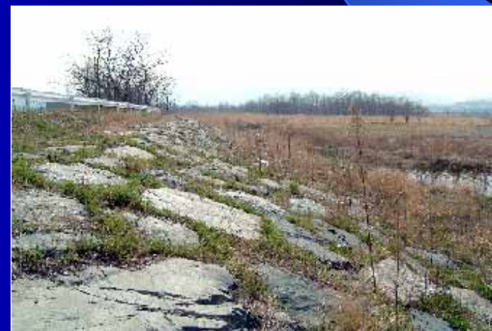
巨石護岸施工事例(神流川)
