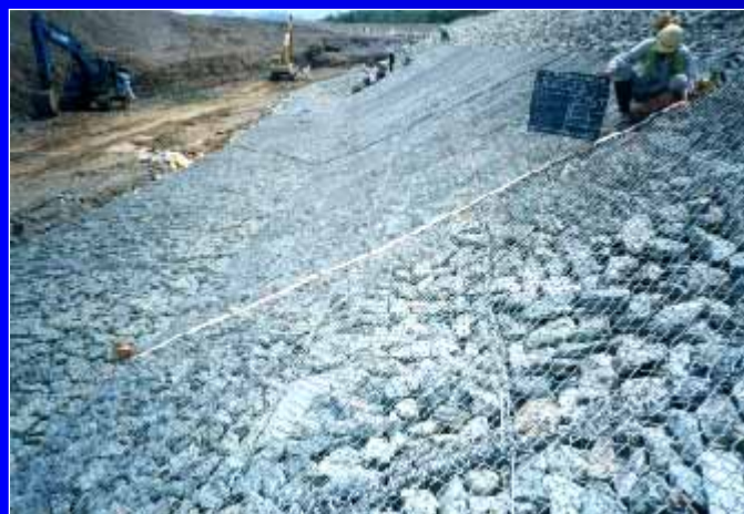
かごマット施工事例(烏川)
