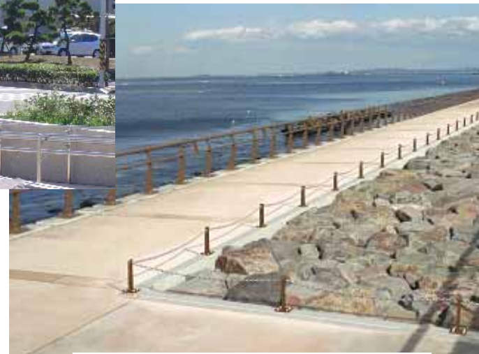
転落防止柵及び進入防止柵
