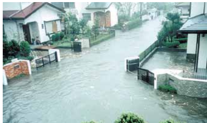
平成8年の台風17号による被害
