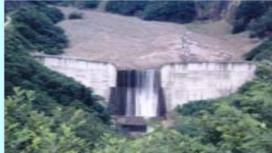
不透過型砂防えん堤
