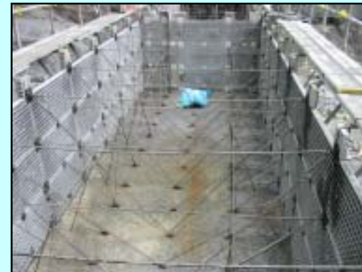
残存型枠工法
