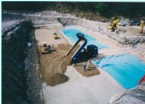
砂防CSG工法
