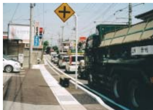
写真② 国道52号南アルプス市の歩道状況
