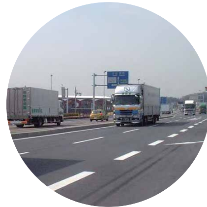
▲桜川市中泉地先の整備後の様子
