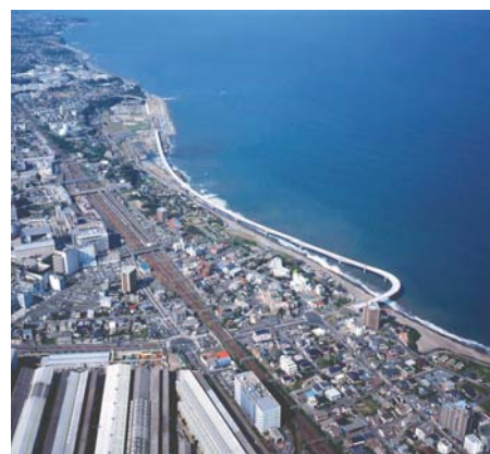
日立バイパス旭高架橋
