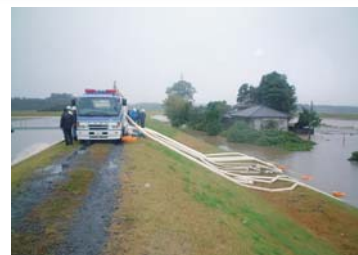
H16年10月玉川の排水ポンプ車作業状況
