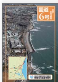
国道6号 水戸～北茨城間
