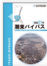
国道51号 潮来バイパス
