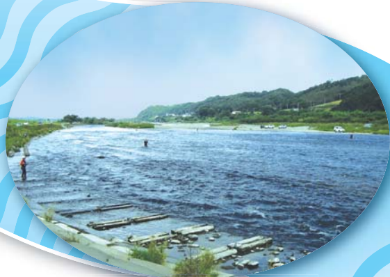
那珂川 (栃木県那珂川町)
