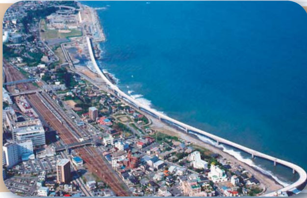
国道6号日立バイパス (茨城県日立市)
