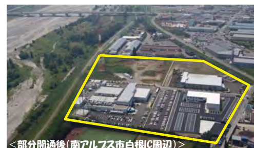
< 部分開通後 (南アルファス市白根IC周辺) >
