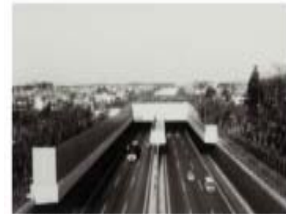
常磐自動車道(半地下構造三郷～柏間)昭和60年
