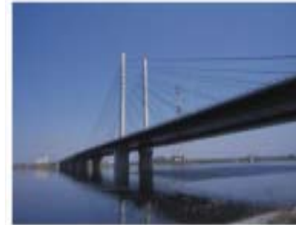
東京外かく環状道路(幸魂大橋) 平成6年
