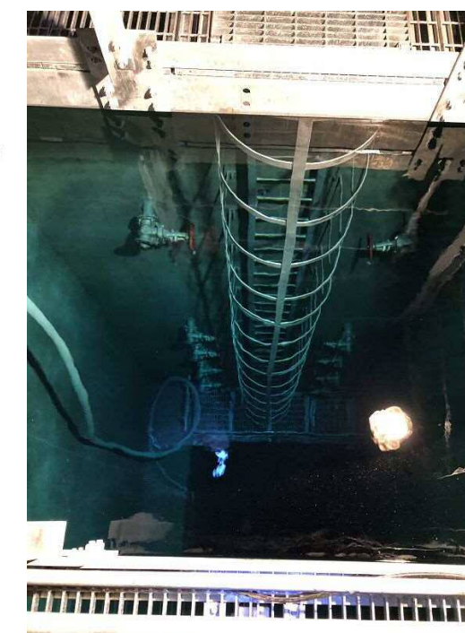
(c) 湛水後の井戸坑内
