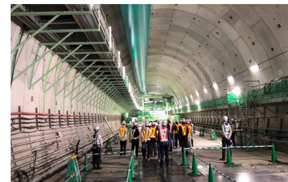
現場視察会の様子 (11/19大泉本線 トンネル坑内)
