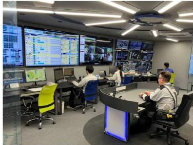
掘進管理状況
