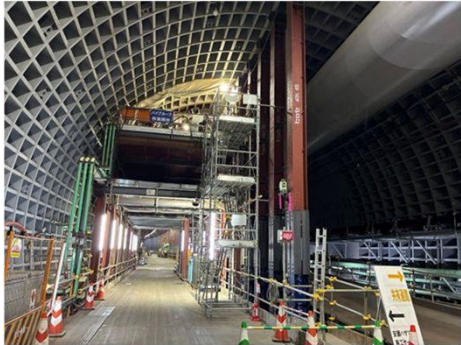
部分拡幅部坑内
