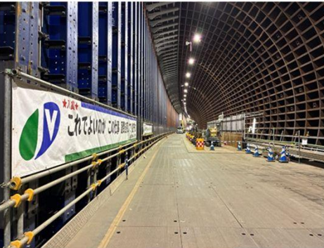
標準拡幅部坑内
