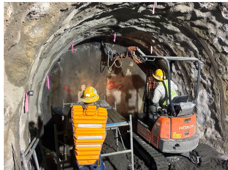
切羽監視員による監視状況
