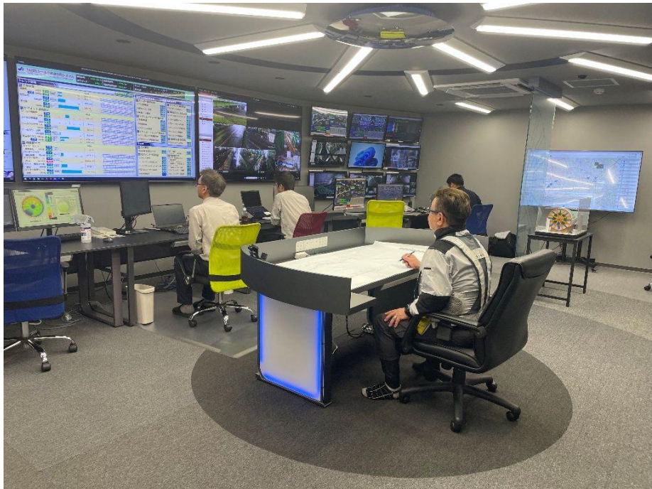
掘進管理状況
