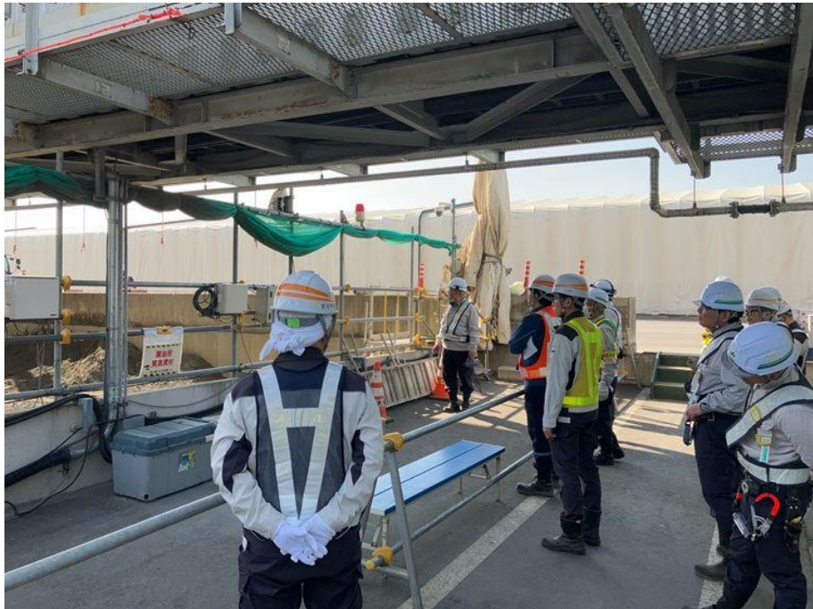
受発注者合同のパトロール（令和 8 年 3 月 23 日）
